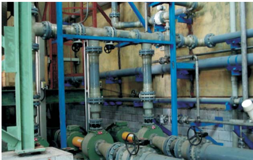
（图22：在高温高压或震动较大的泵出口、热交换器出口建议用玻璃钢加强）
