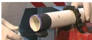
8. 胶粘剂涂抹管道
