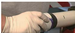
11. 边推至底部边旋转1/4圈，按住30秒防止反弹
