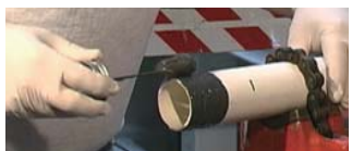
10. 胶粘剂再次涂抹管道
