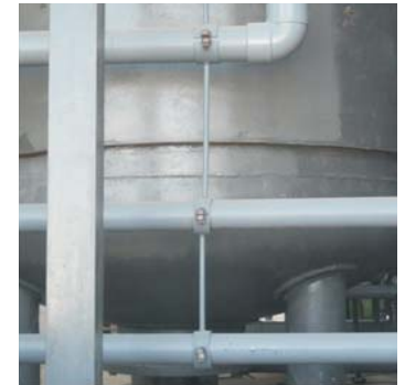
(图20: 连续吊挂支架制作) 注: 管材不能摆动
