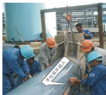
(图9: 手拉葫芦插入和吊带捆绑配管)
