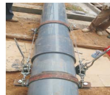
(图10: 管卡夹紧和拉紧器插入配管)
