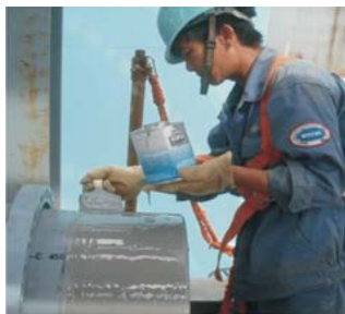
(图7: dn280以上管材胶水的涂抹)
