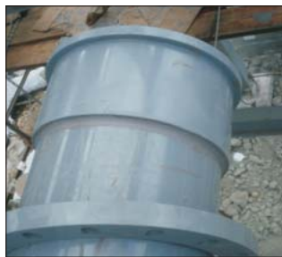
(图8: 胶水均匀溢出一圈的视觉效果)
