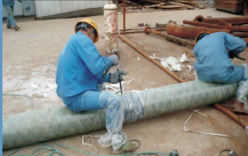
(图6：剥除缠绕在管道外面的玻璃钢)
