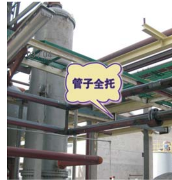
(图17: 小口径管全托支架)
