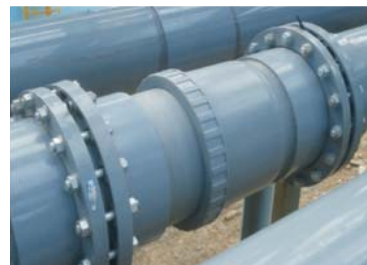
(图11: PVC-C抽拉式伸缩接)
