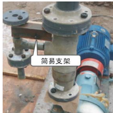
(图16: 泵出口典型支架)
