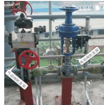
(图19: 电动、气动阀支架的安装制作) 注: 管材不能承担到阀门的重量
