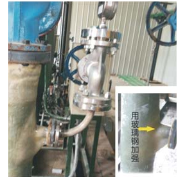
(图18: 三角板和玻璃钢加强支撑)
